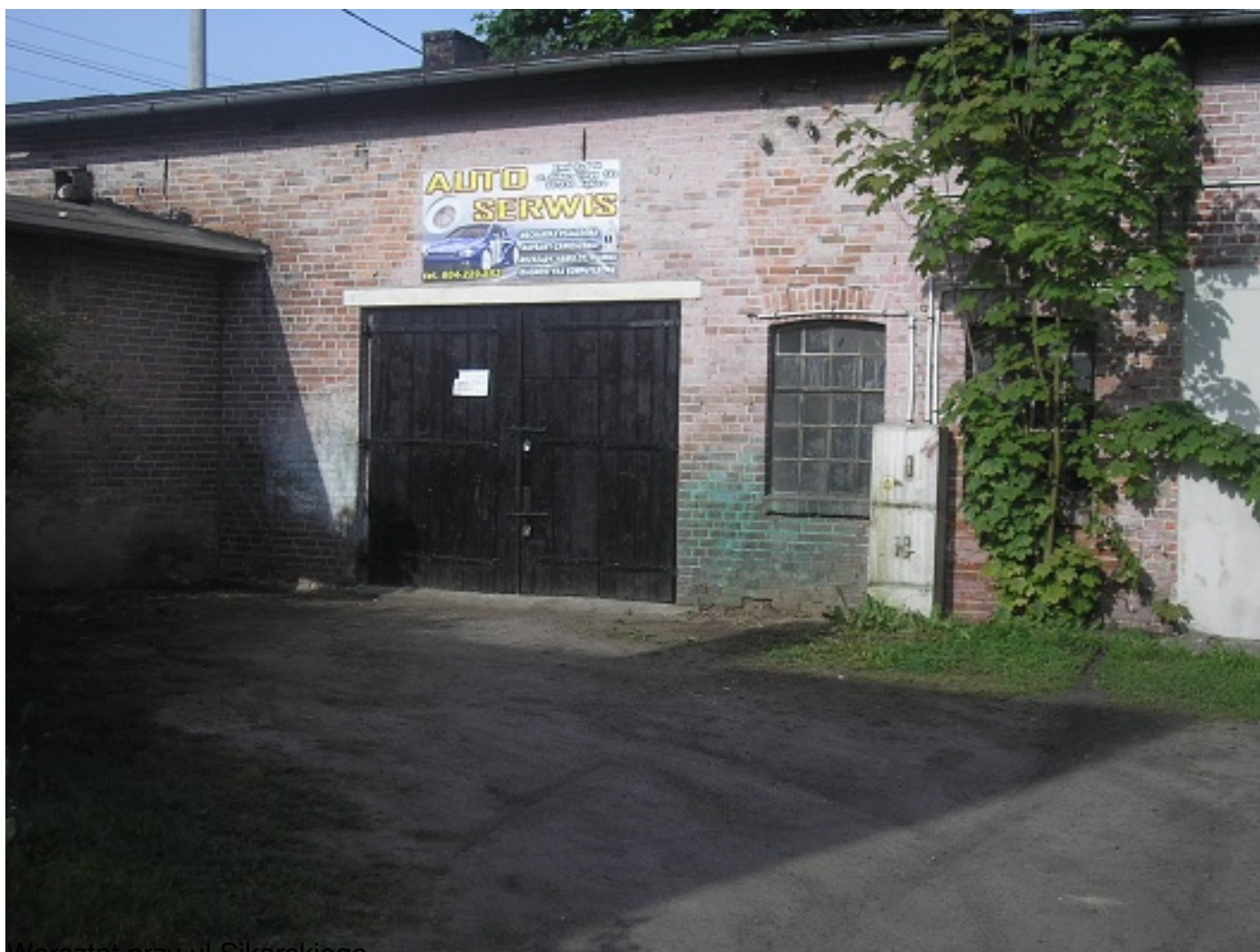
warsztat przy ul. Sikorskiego
